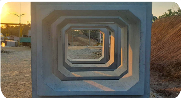
● Box Culvert IKN
