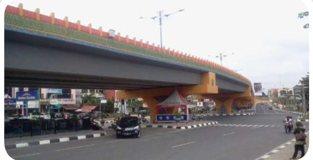
● PCU Girder Tanjung Siapi-api Fly Over
